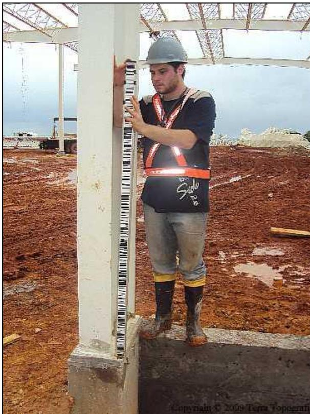
Figura IV.10 – Nivelamento com nível Eletrônico. Detalhe da mira com código de barras
